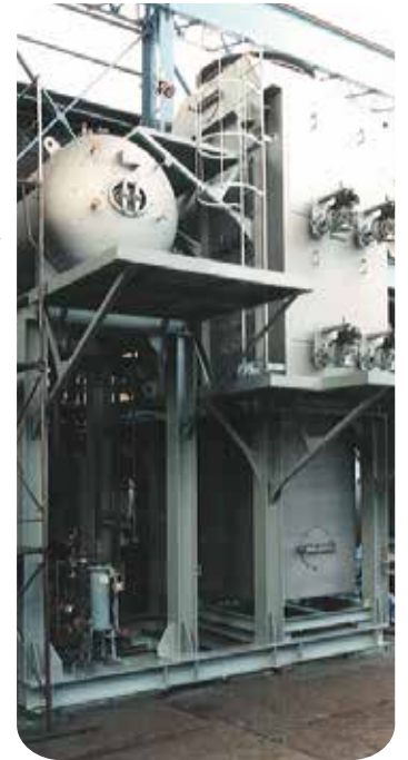
内燃機コージェネ発電用途 立型排熱回収ボイラ
